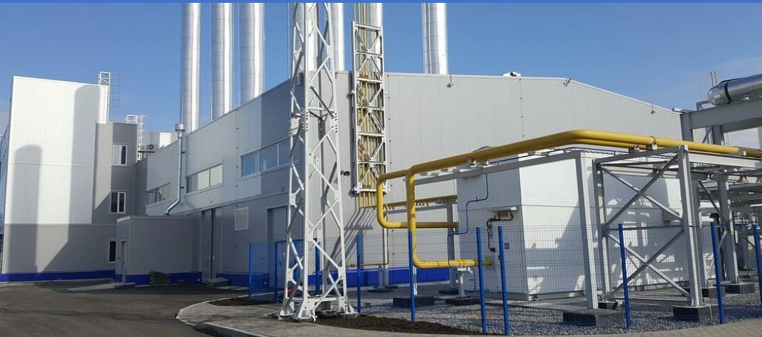
Газотурбинная тепловая электростанция (ГТУ-ТЭС) в г. Елабуга
